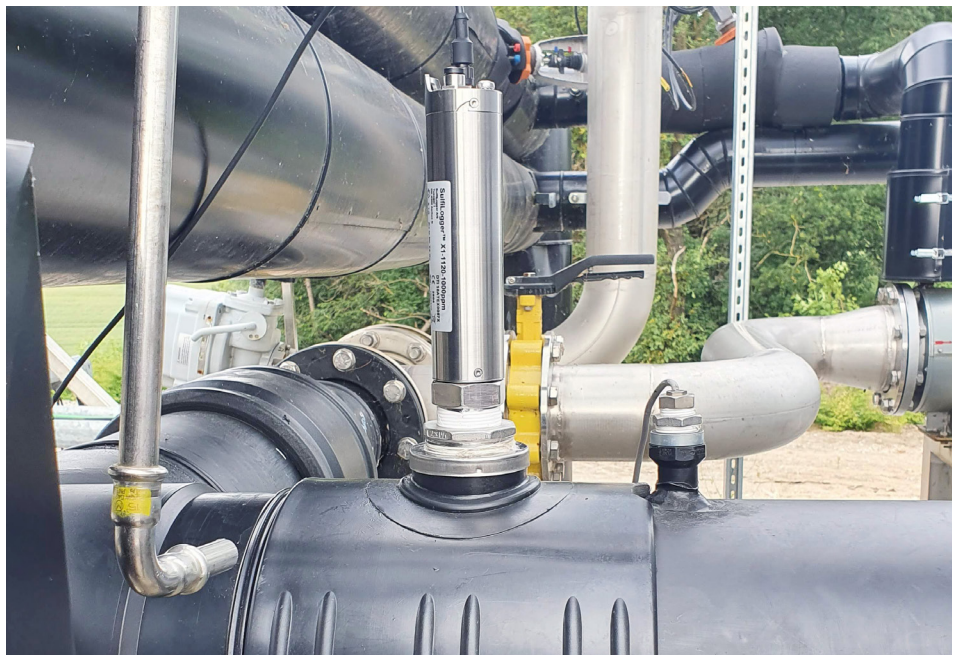
Der SulfiLogger™ H 2 S-Sensor bei Hærup Biogas. Er misst direkt Im-Rohr, nach dem Biofilter.
