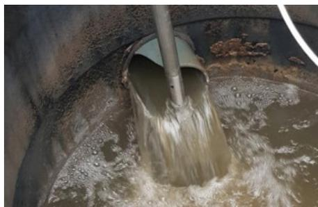
SulfiLogger™-sensoren målte direkte i indløbet til oppumpningsbrønden.
